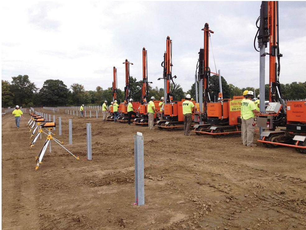
Слика 11. Приказ на машинерија за набивање на столбовите во земја
